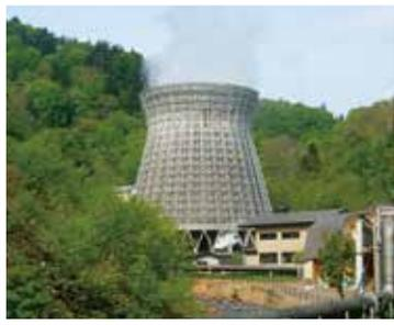
国内初の商業用地熱発電所として昭和41年10月から運転を開始。発電所の象徴となっている建物(写真)は、発電で使用した水蒸気を冷やすための冷却塔です。
