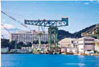
長崎港の中央にそびえる、日本に初めて設置された三菱長崎造船所の電動クレーン。150tの吊上能力を持ち、電動モーターで駆動するものです。空爆や原爆の被害を免れ、現在も大型製品を出荷する際に活躍する現役の施設です。対岸のグラバー園からはその勇壮な姿を見ることができます。
